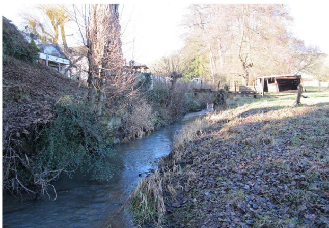
Foto gegen Fließrichtung
