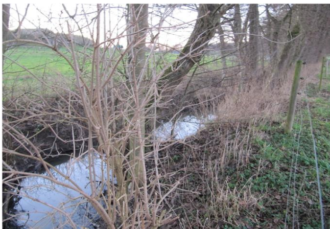
Foto gegen Fließrichtung
