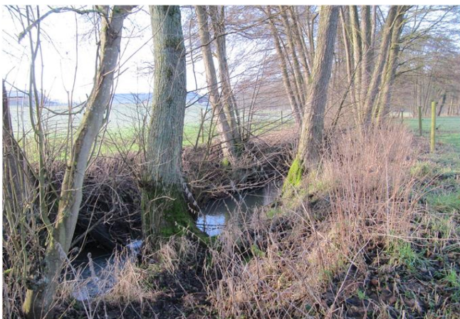
Foto gegen Fließrichtung
