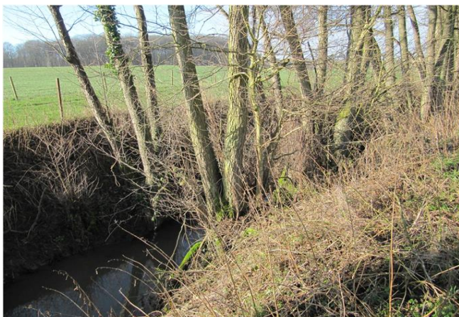
Foto gegen Fließrichtung
