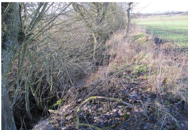
Foto gegen Fließrichtung
