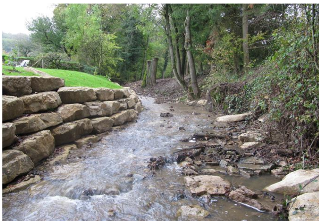
Foto gegen Fließrichtung
