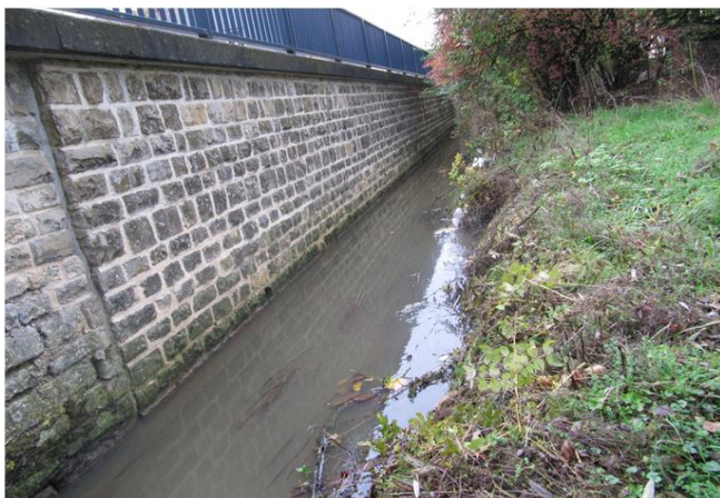
Foto gegen Fließrichtung
