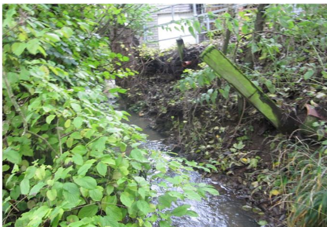
Foto gegen Fließrichtung
