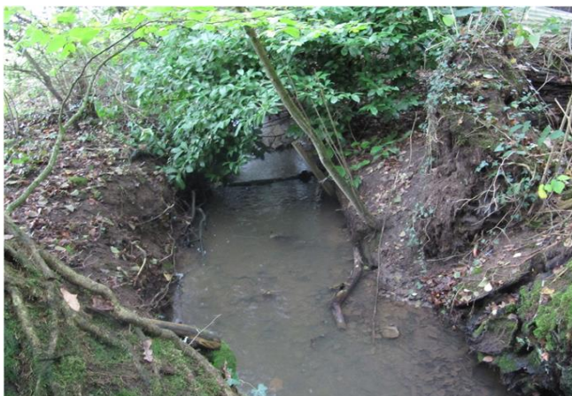
Foto gegen Fließrichtung
