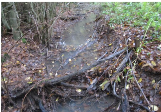
Foto gegen Fließrichtung
