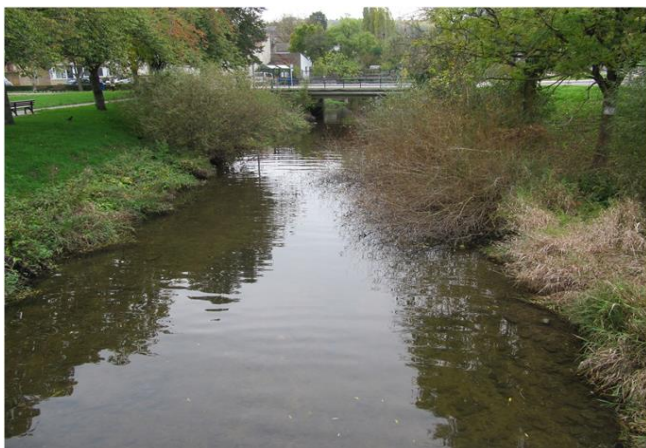
Foto gegen Fließrichtung
