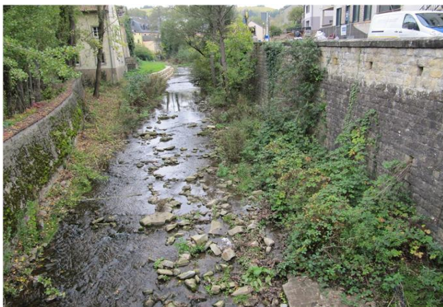
Foto gegen Fließrichtung
