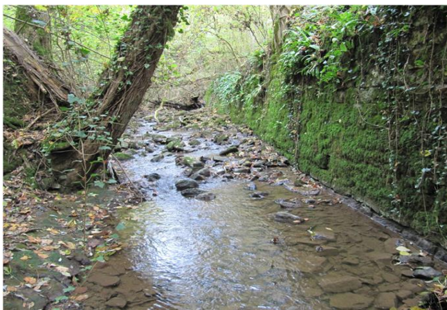
Foto gegen Fließrichtung
