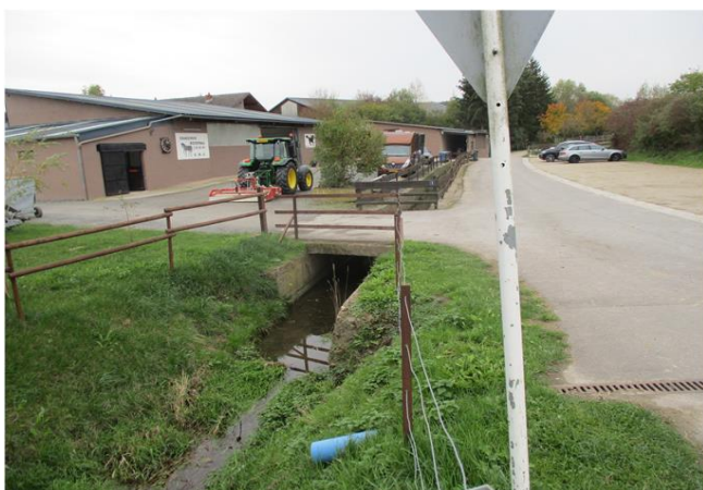
Foto gegen Fließrichtung
