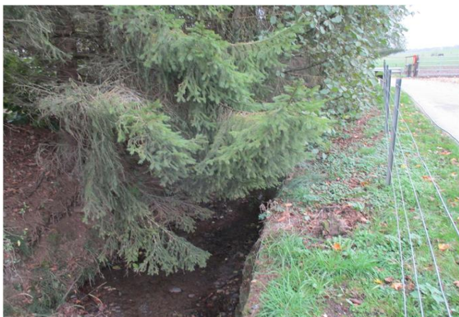
Foto gegen Fließrichtung
