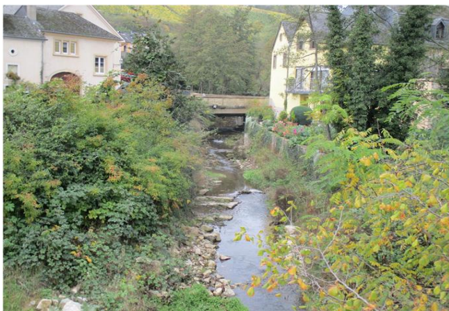
Foto gegen Fließrichtung
