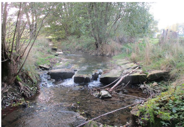
Foto gegen Fließrichtung
