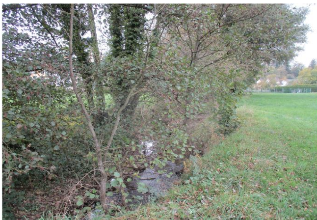
Foto gegen Fließrichtung
