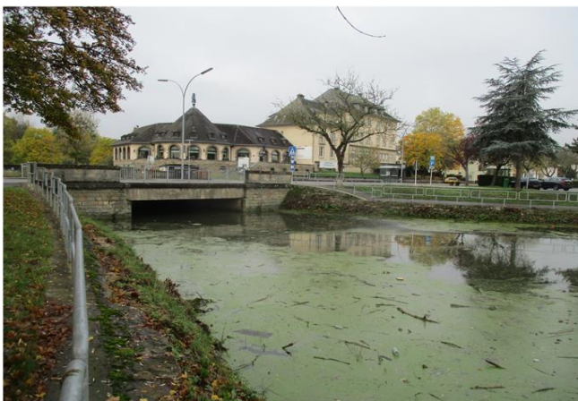
Foto gegen Fließrichtung
