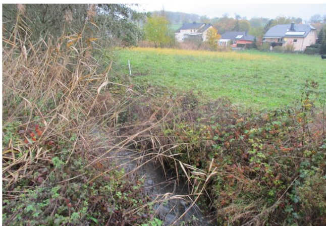
Foto gegen Fließrichtung
