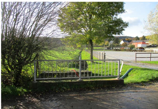
Foto gegen Fließrichtung
