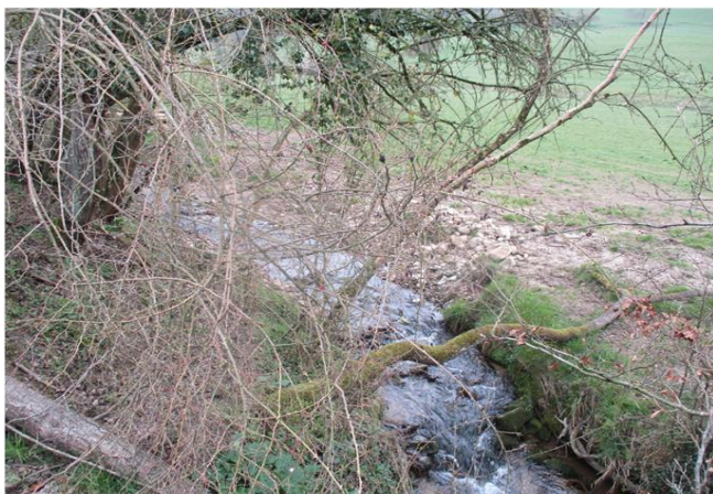
Foto gegen Fließrichtung
