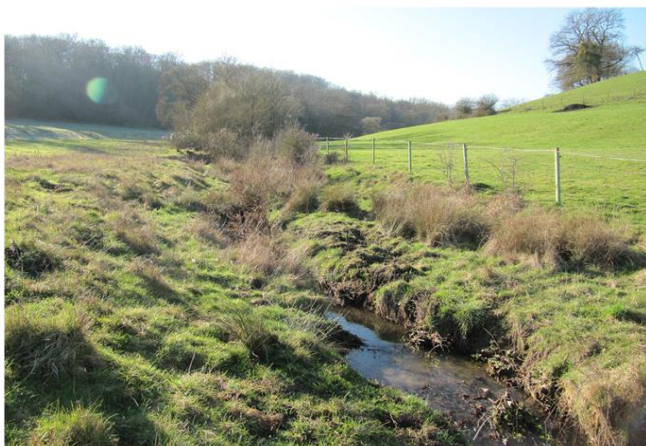
Foto gegen Fließrichtung
