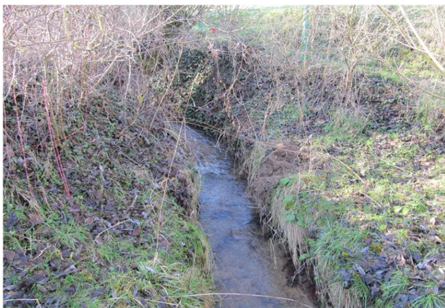
Foto gegen Fließrichtung
