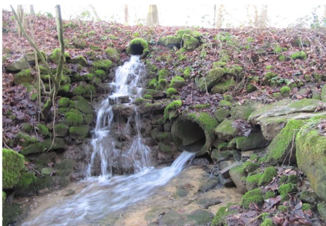
Foto gegen Fließrichtung
