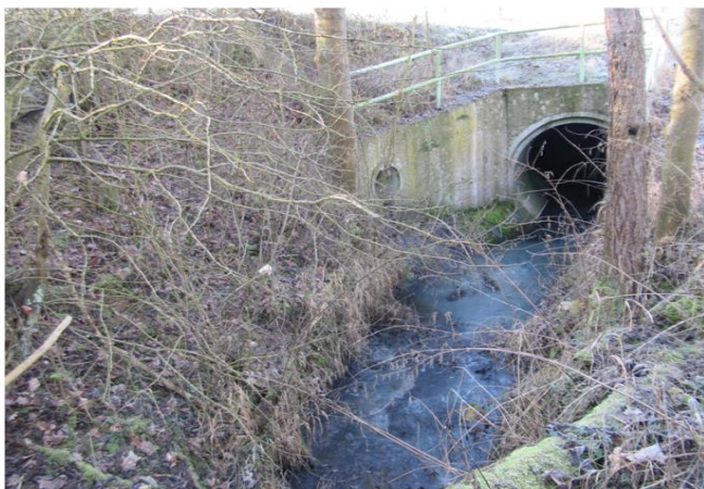
Foto gegen Fließrichtung
