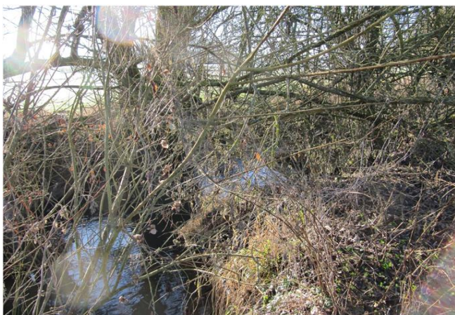
Foto gegen Fließrichtung
