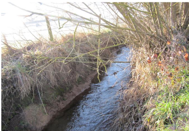
Foto gegen Fließrichtung
