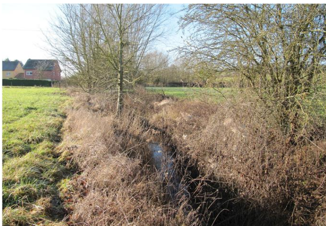
Foto gegen Fließrichtung
