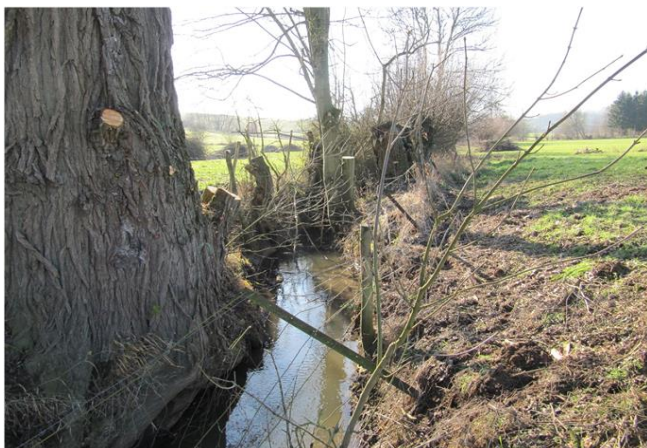
Foto gegen Fließrichtung
