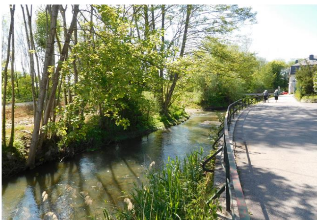
Foto gegen Fließrichtung
