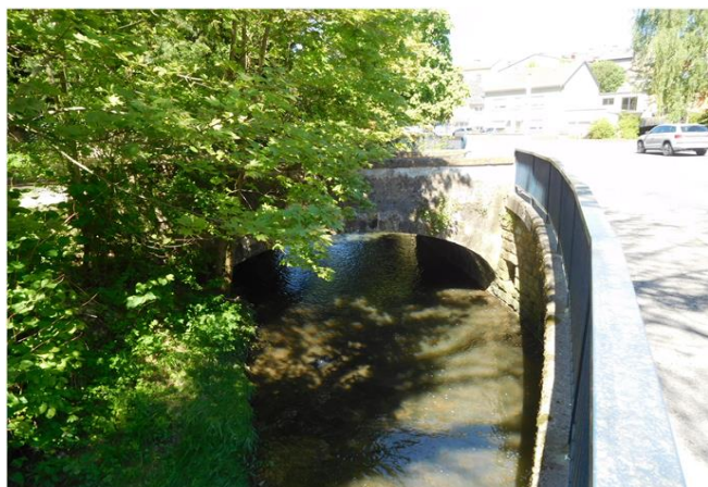
Foto gegen Fließrichtung
