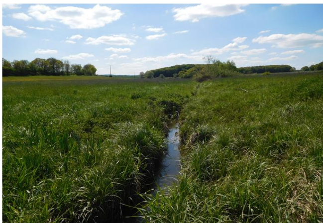
Foto gegen Fließrichtung
