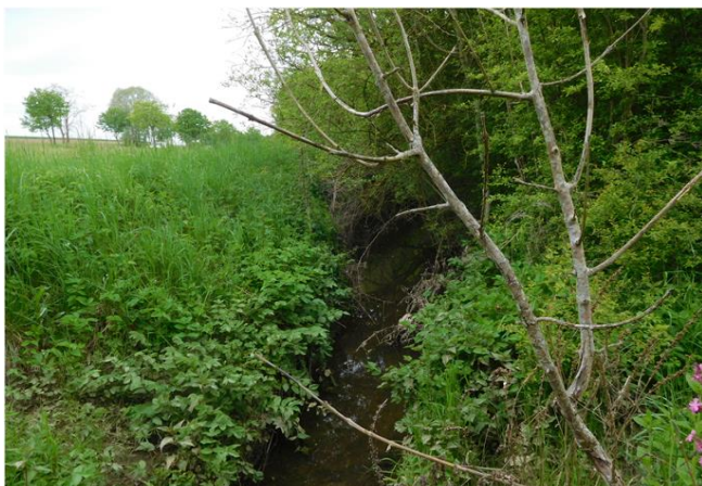
Foto gegen Fließrichtung
