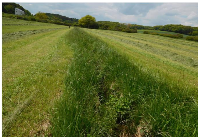
Foto gegen Fließrichtung
