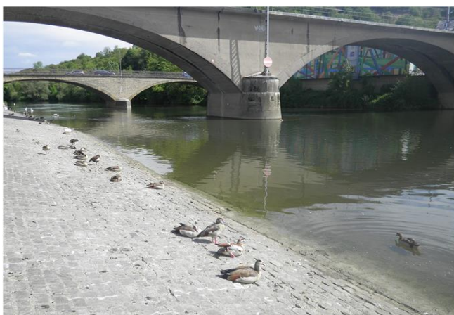
Foto gegen Fließrichtung
