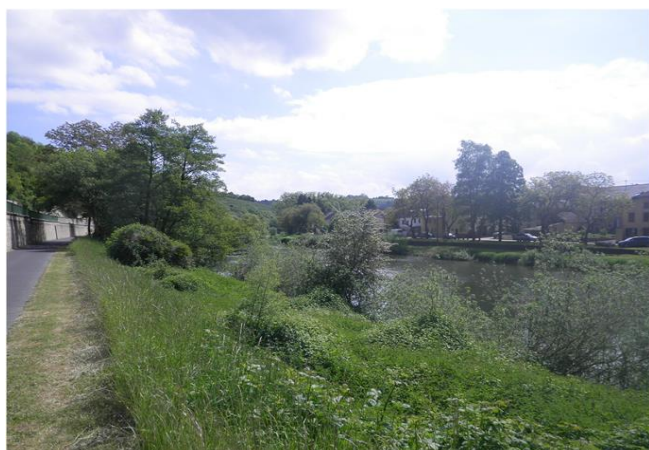
Foto gegen Fließrichtung
