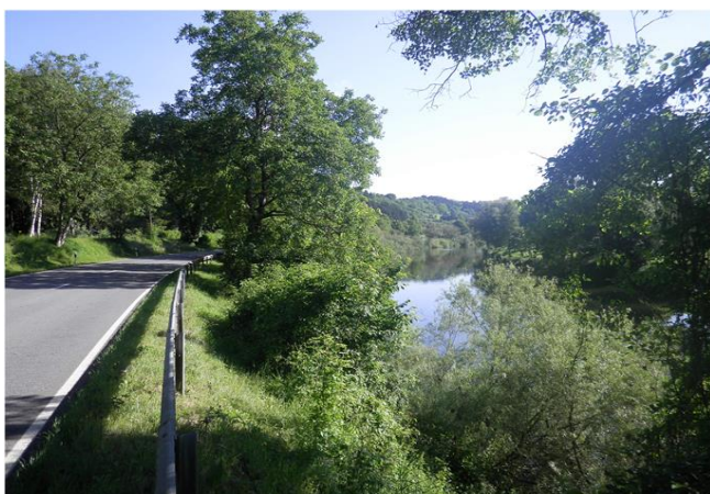
Foto gegen Fließrichtung
