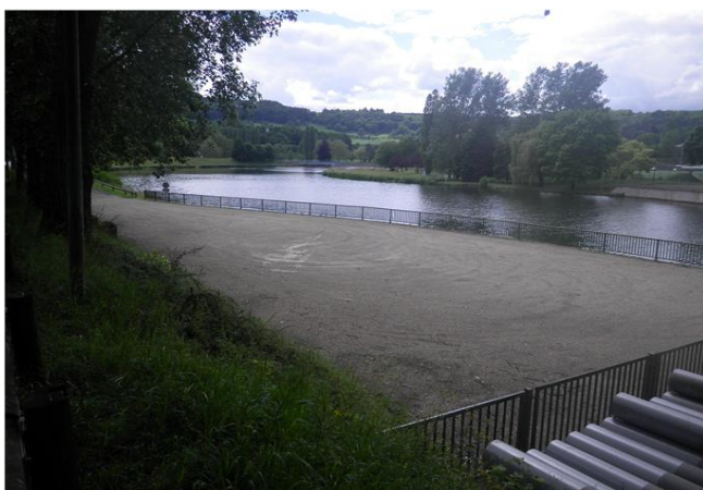
Foto gegen Fließrichtung
