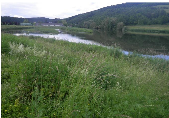
Foto gegen Fließrichtung
