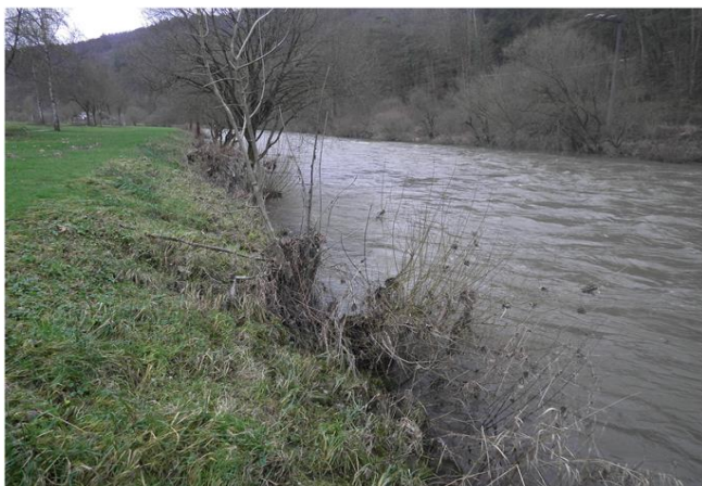
Foto gegen Fließrichtung
