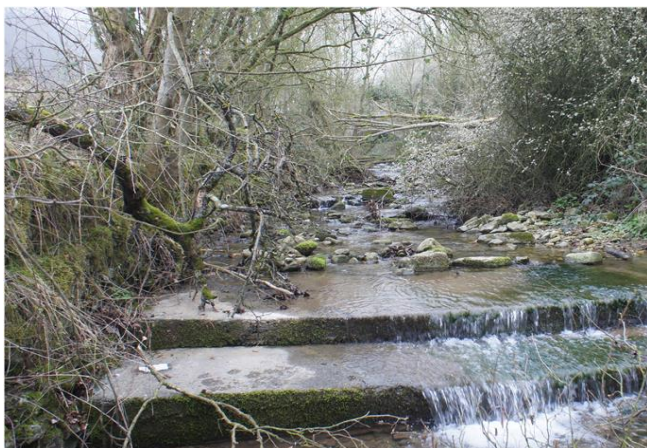
Foto gegen Fließrichtung
