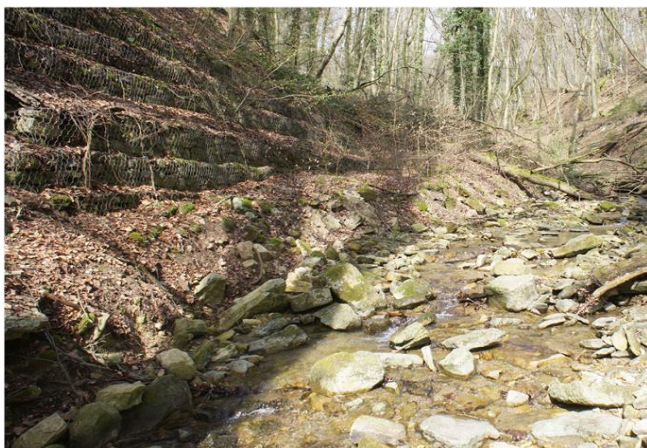
Foto gegen Fließrichtung
