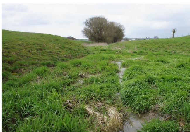
Foto gegen Fließrichtung
