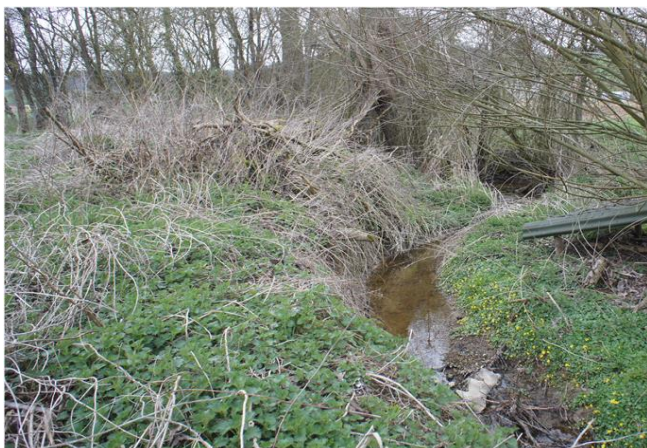
Foto gegen Fließrichtung
