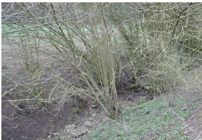
Foto gegen Fließrichtung
