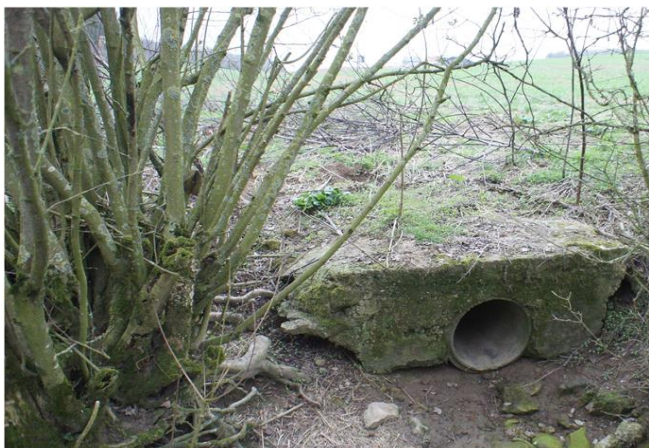
Foto gegen Fließrichtung
