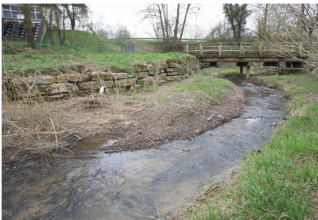
Foto gegen Fließrichtung
