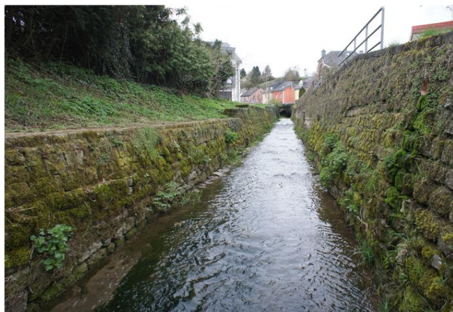
Foto gegen Fließrichtung
