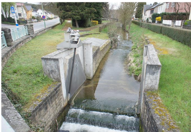
Foto gegen Fließrichtung
